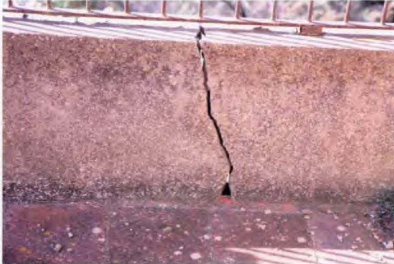
FOTO 10: Particolare Fessura muro di sostegno. Evidenzia un cedimento differenziale delle strutture e cedimento fondale del situ.
