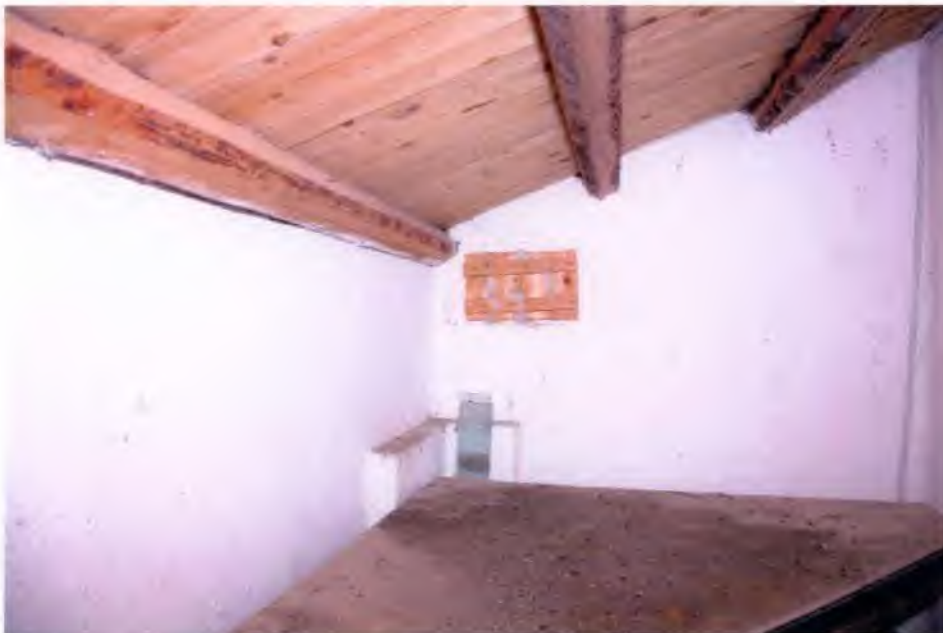
FOTO 24: Particolare delle travi in legno della copertura del corpo B- Si evidenzia la manca di cordolo in c.a.
