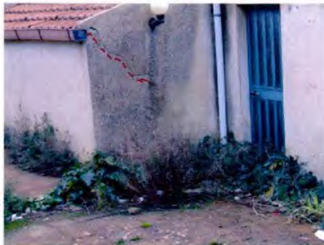
Foto n° 10 Lesione inclinata, che interessa un tratto del fabbricato, dovuta a un cedimento differenziale. Si nota un pluviale che scarica le acque del tetto in un punto del cortile inopportuno.
