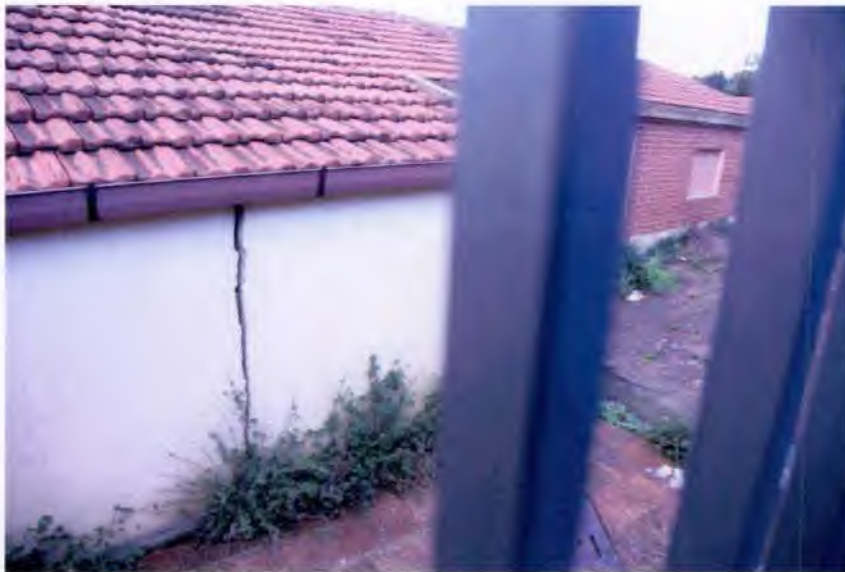
FOTO 3: Particolare Fessurazione corpo B.
