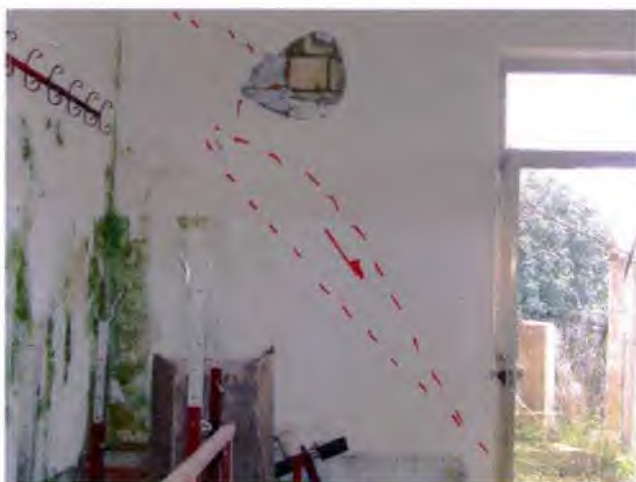
Foto n° 3 Lesione di sforzo tensionale che interessa il muro portante del locale seminterrato, lato sud. Nella superficie del muro adiacente sono visibili segni di emergenze idriche la cui infiltrazione avviene nel cortile sovrastante.
