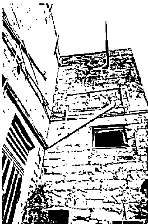
Fig. 3 – Distaccamento verticale del Corpo B dal corpo A
