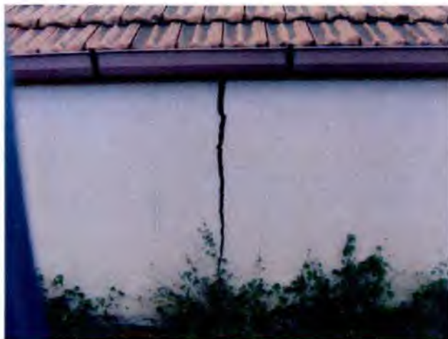
Foto n° 9 Lesione di distacco di un corpo aggiunto al fabbricato principale in un periodo successivo.
