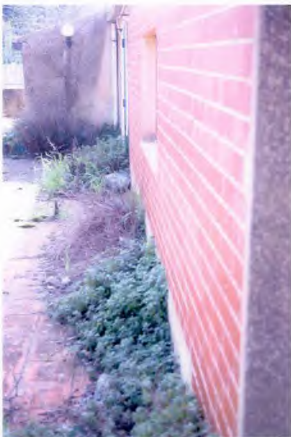
FOTO 9: Particolare prospetto Nord corpo A e corpo B- si evidenzia il muro non in linea del corpo B.
