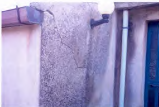
FOTO 8: Particolare fessura a 45° del prospetto Nord del corpo B.
