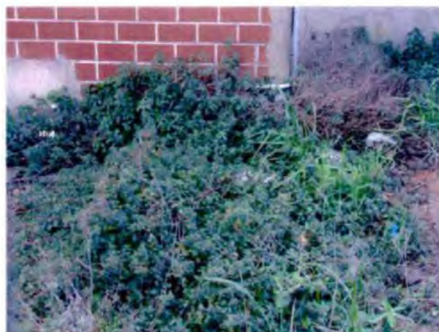
Foto n° 11 Particolare di uno scarico di acque piovane nelle vicinanze della fondazione del fabbricato. Il criterio adottato è sbagliato perché a breve ed a lungo termine le infiltrazioni idriche provocano cedimenti delle fondazioni.
