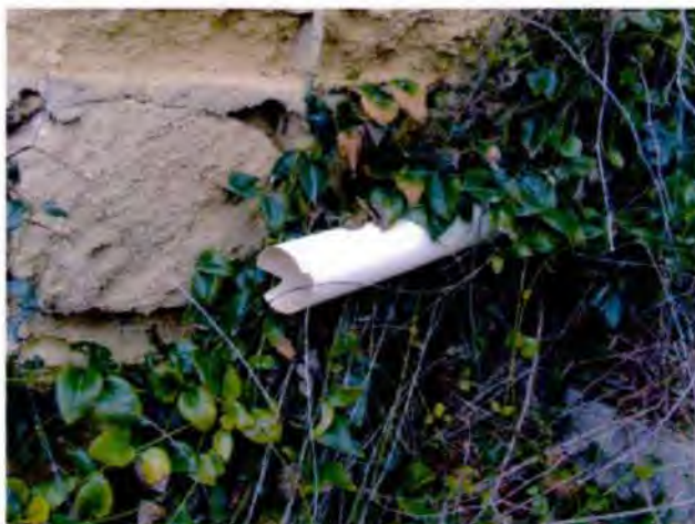
Foto n° 11 Particolare di uno scarico di acque piovane nelle vicinanze della fondazione del fabbricato. Il criterio adottato è sbagliato perché a breve ed a lungo termine le infiltrazioni idriche provocano cedimenti delle fondazioni.
