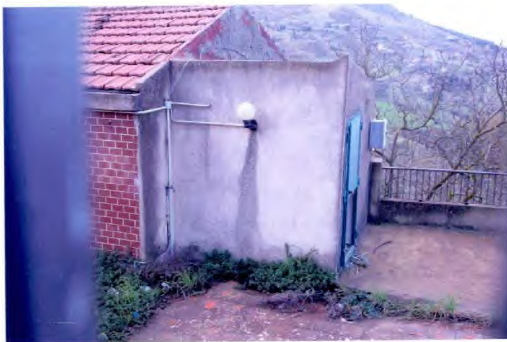
FOTO 32 : Particolare corpo C – si evince come la struttura murario sia appoggiato senza connessione al corpo A, e sia mancante di cordolo in c.a., con scarsa o inesistente costituzione di fondazione.
