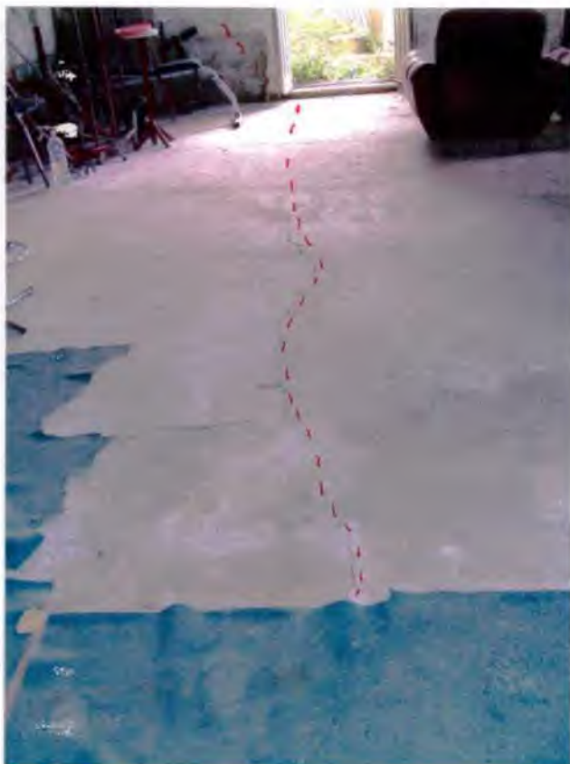
Foto n° 2 Lesione longitudinale che attraversa il pavimento del locale seminterrato.
