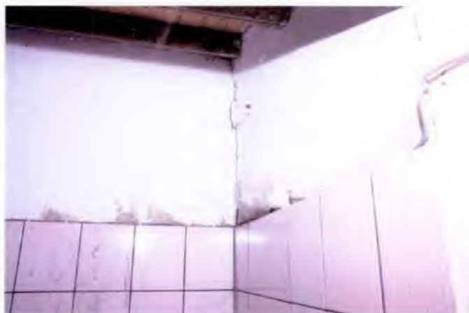
FOTO 16: Particolare fessura parte sud del corpo B
