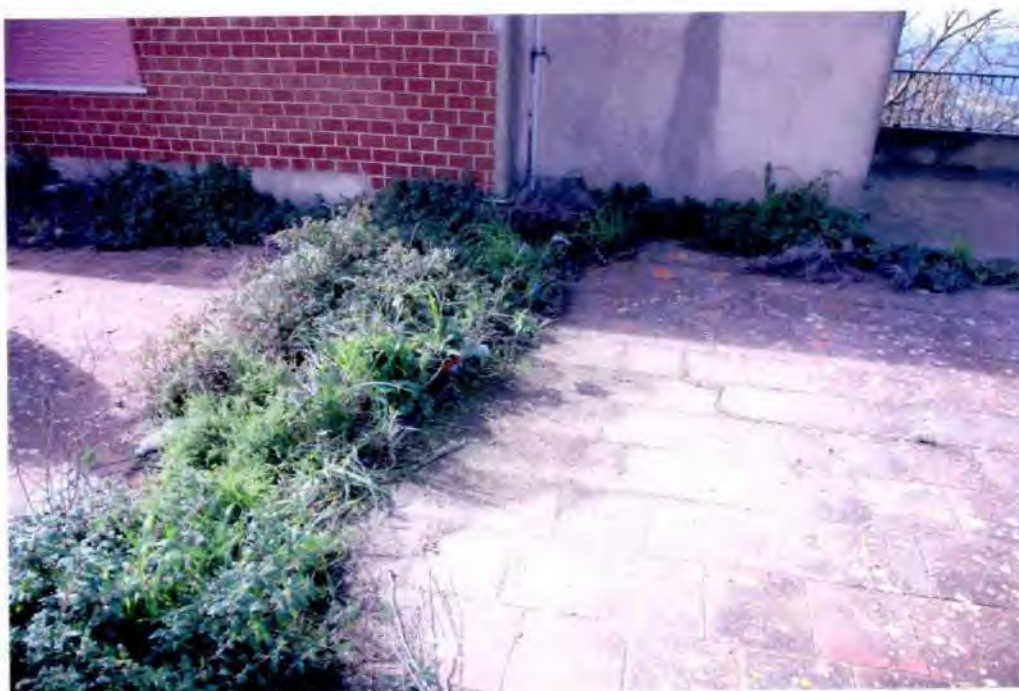
FOTO 33 : Particolare dello spiazzale con evidente crescita di erba dovuta a costante infiltrazione d'acqua nel sottosuolo.
