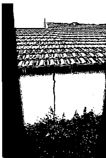
Fig. 1 - Fessurazione Verticale nel Corpo B
