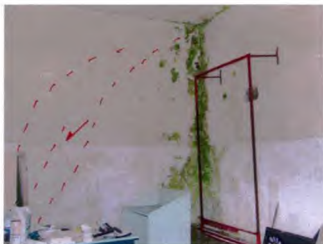
Foto n° 4 Lesione di sforzo tensionale che interessa il muro portante del locale seminterrato, lato nord. Nella superficie del muro sono visibili segni di emergenze idriche la cui infiltrazione avviene nel cortile sovrastante.
