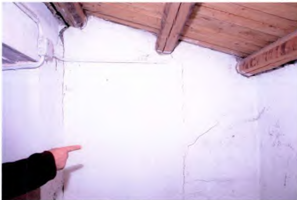
FOTO 18: Particolare lesioni nel corpo B.
